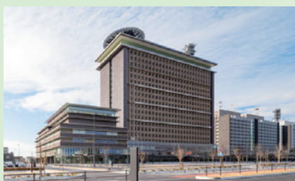
岐阜県庁舎行政棟
