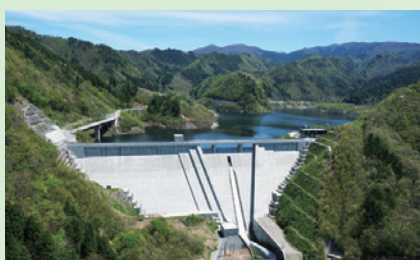
丹生川多目的ダム
