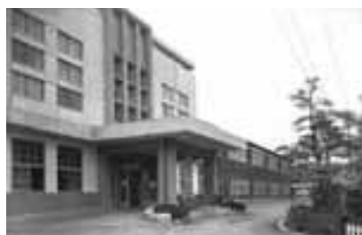
旧本館正面玄関からの校舎
