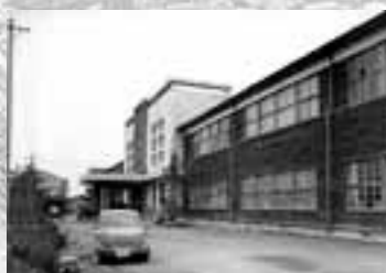
旧本館東からの校舎
